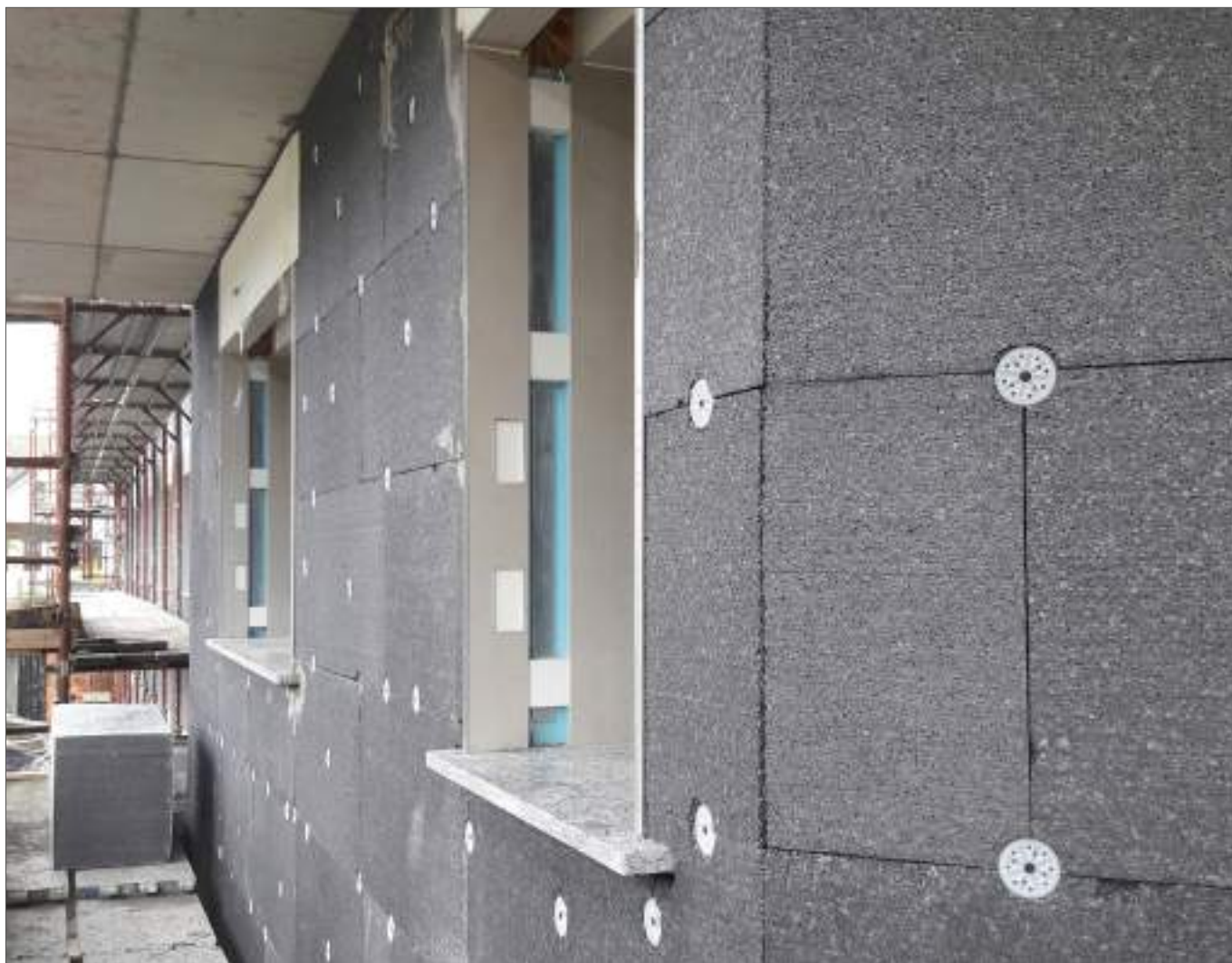
Isolant plastique utilisé dans le secteur de la construction / Alfons Ven / AdobeStock
